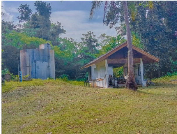
๙. อาคารผลิตน้ำประปาพร้อมระบบจ่ายน้ำ
