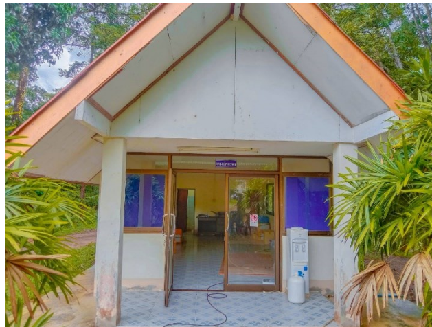
๒๐. อาคารงานปกครอง จำนวน ๑ หลัง ลักษณะอาคาร : อาคารชั้นเดียว ทรงจั่ว วันที่ได้รับ : สร้างเมื่อปี ๒๕๔๗ ราคาก่อสร้าง : ใช้งบวัสดุฝึก ( ประมาณ ๒๐๐,๐๐๐ บาท )
